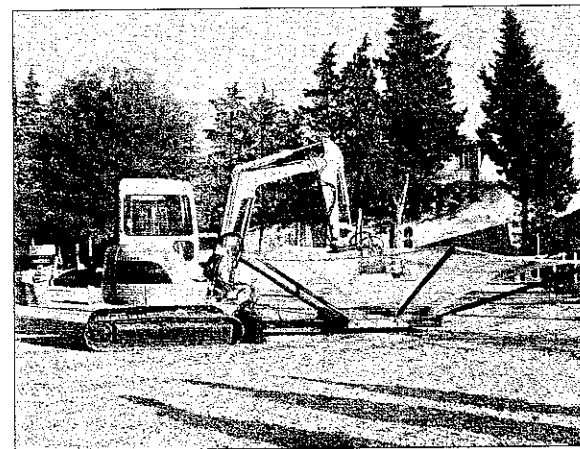
Il cantiere sperimentale basato sull'impiego di un escavatore cingolato.
